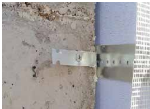
Foto 4. Fissaggio esterno con turbovite
