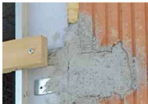
Foto 6. Riempimento spaccatura con malta cementizia
