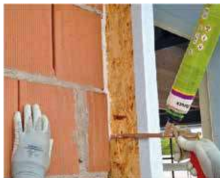
Foto 7. Applicazione schiuma per fissaggio monoblocco
