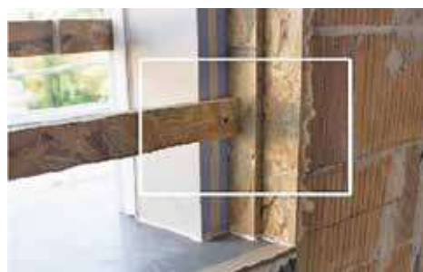
Foto 3. Fissaggio interno con turbovite
