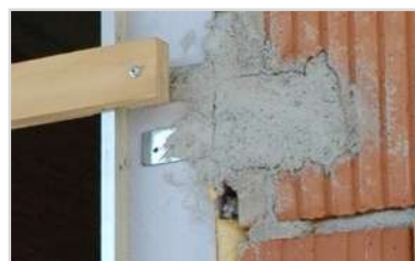
Foto 6. Riempimento spaccatura con malta cementizia
