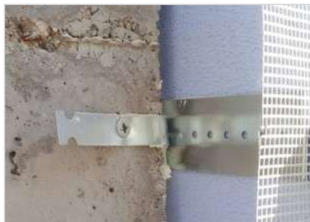
Foto 4. Fissaggio esterno con turbovite
