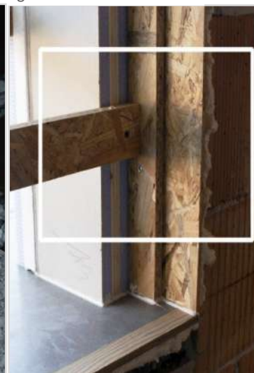
Foto 3. Fissaggio interno con turbovite
