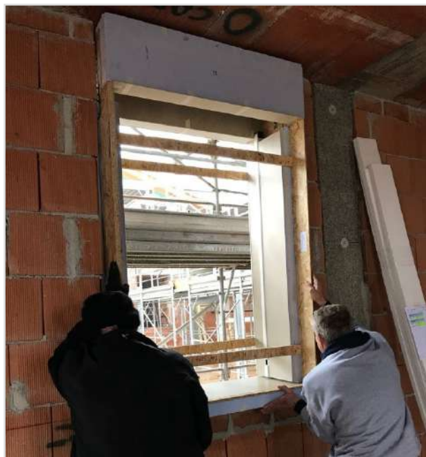
Foto 1. Inserimento monoblocco nel foro grezzo
