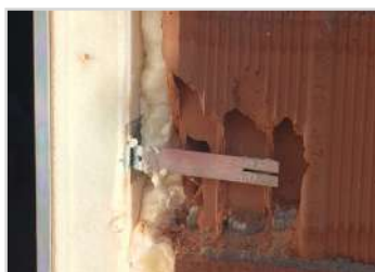
Foto 5. Apertura zanca su spaccatura laterizio
