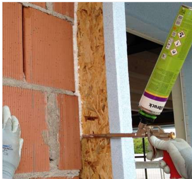
Foto 7. Applicazione schiuma per fissaggio su monoblocco
