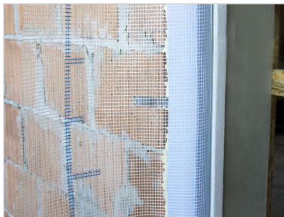
Foto 10. Rete anti-fessurazione applicata esternamente
