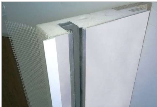
Foto 9. Rete anti-fessurazione per finitura ad intonaco
